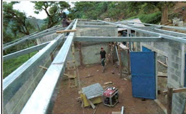
Foto 2: MEJORAMIENTO DE TECHO ESTRUCTURAL
