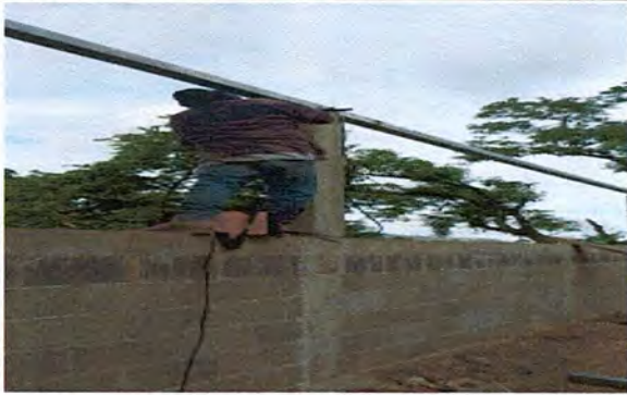
Foto 1: MEJORAMIENTO DE TECHO ESTRUCTURAL
