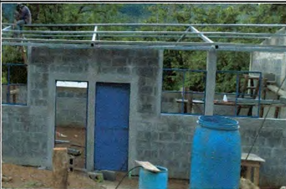
Foto 3: MEJORAMIENTO DE TECHO ESTRUCTURA METALICA
