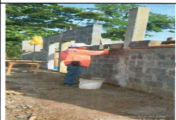
Foto 4: MEJORAMIENTO DE PAREDES DE MODULOS
