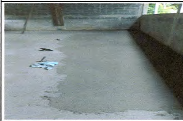
Foto 4: MEJORAMIENTO TORTA DE CEMENTO RUSTICA
