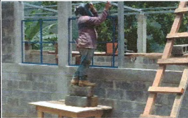
Foto 1: MEJORAMIENTO DE VENTAS Y PUERTAS
