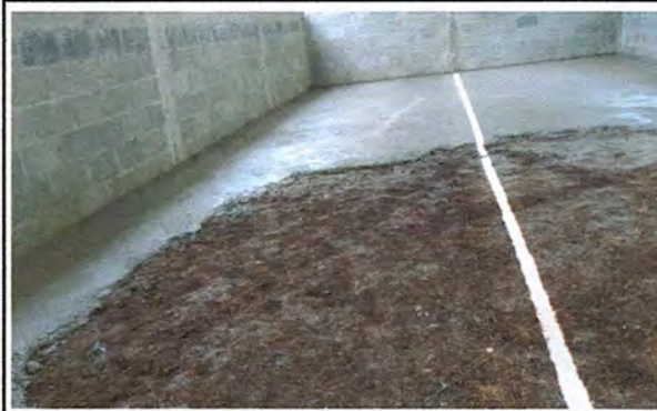
Foto 2: MEJORAMIENTO TORTA DE CEMENTO RUSTICA
