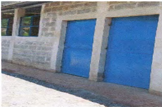
Foto 3: MEJORAMIENTO DE PUERTAS Y VENTANAS
