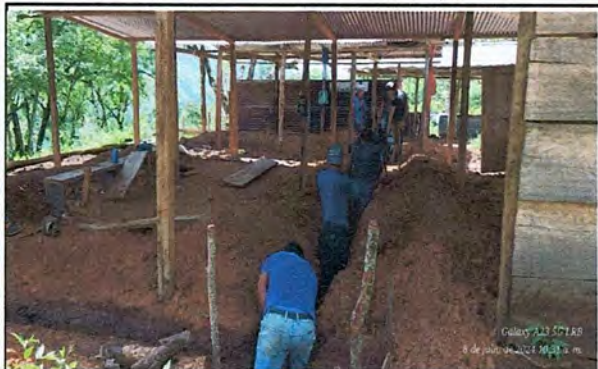
Foto 1: MEJORAMIENTO DE PAREDES DE MODULOS
