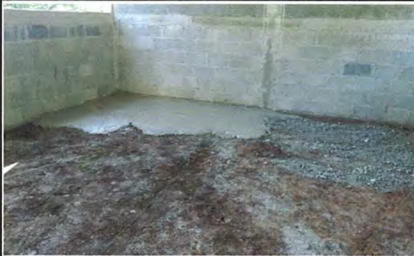
Foto 1: MEJORAMIENTO TORTA DE CEMENTO RUSTICA
