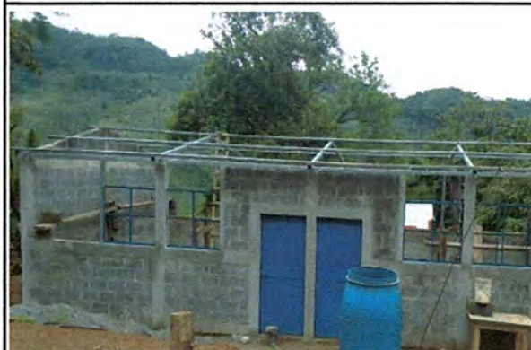
Foto 4: MEJORAMIENTO DE TECHO, ESTRUCTURA METALICA
