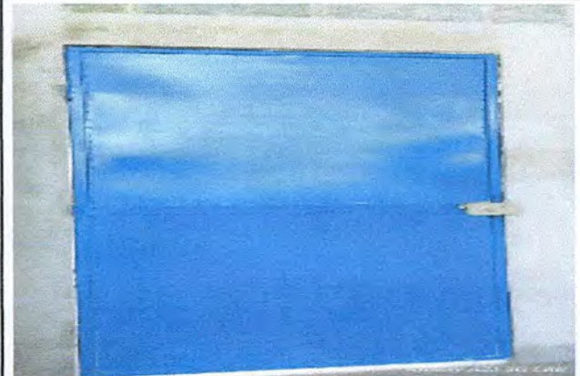
Foto 4: MEJORAMIENTO DE PUERTAS Y VENTANAS
