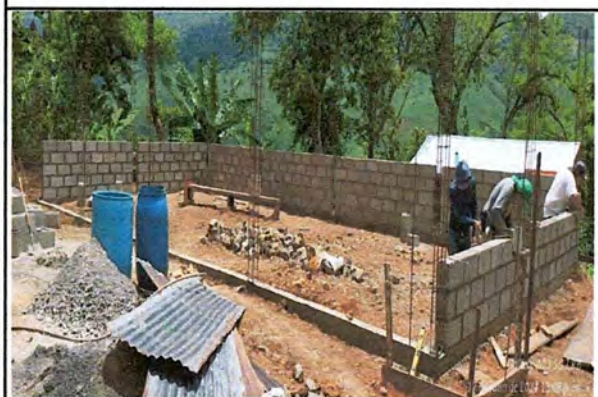
Foto 3: MEJORAMIENTO DE PAREDES DE MODULOS
