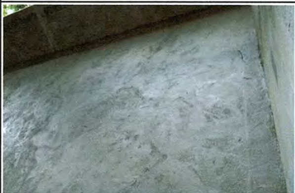
Foto 3: MEJORAMIENTO TORTA DE CEMENTO RUSTICA
