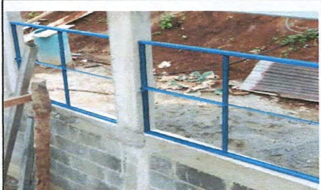
Foto 2: MEJORAMIENTO DE VENTANAS Y PUERTAS
